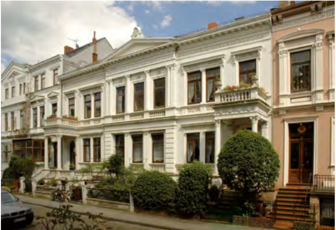
Abb. 4 Bremen, typische Wohnbebauung mit Bremer- Häusern
