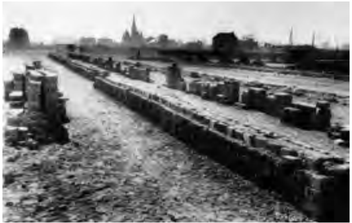
Abb. 6 Trümmerverwertung, Backstein-Recycling
