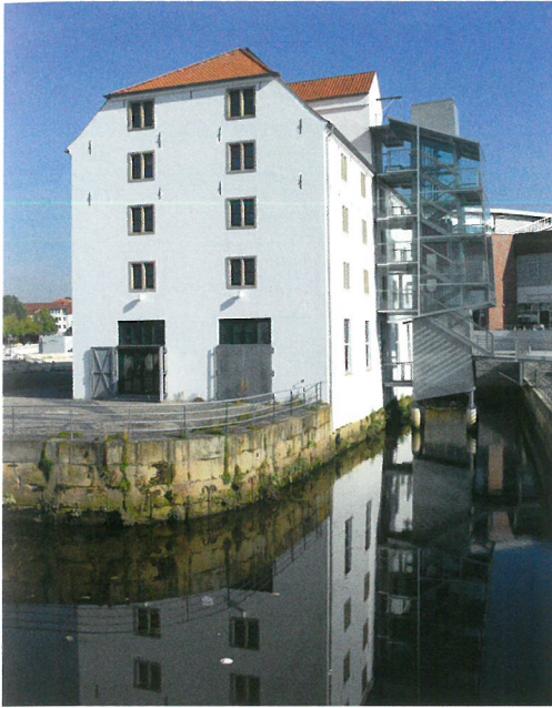
Abb. 2 Bremen, Vegesack: Lange-Speicher, Außenerschließung.
