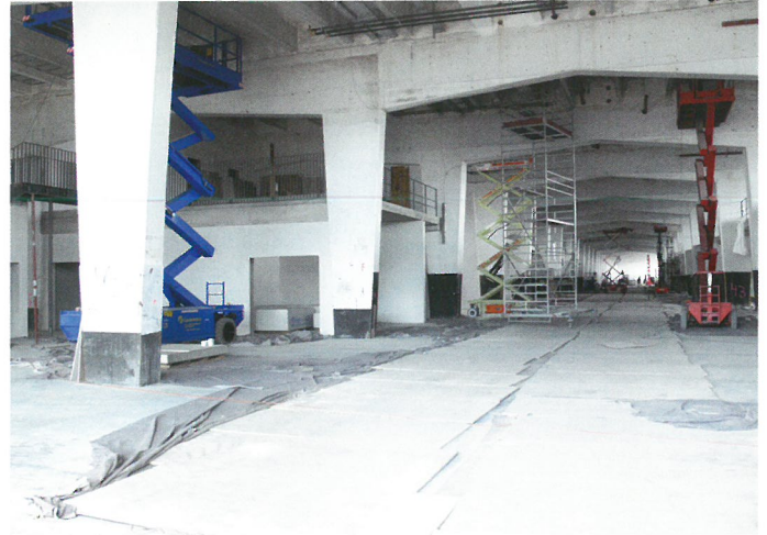
Abb. 8 Bremen, Überseestadt: Schuppen 1, Autowelt, während Umbau.
