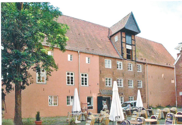
Abb. 3: Bremen, Vegesack, Speicher 17. Jh.
