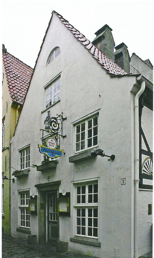
Abb. 1: Bremen, Schnoor: Speicher, Anfang 15. Jh.
