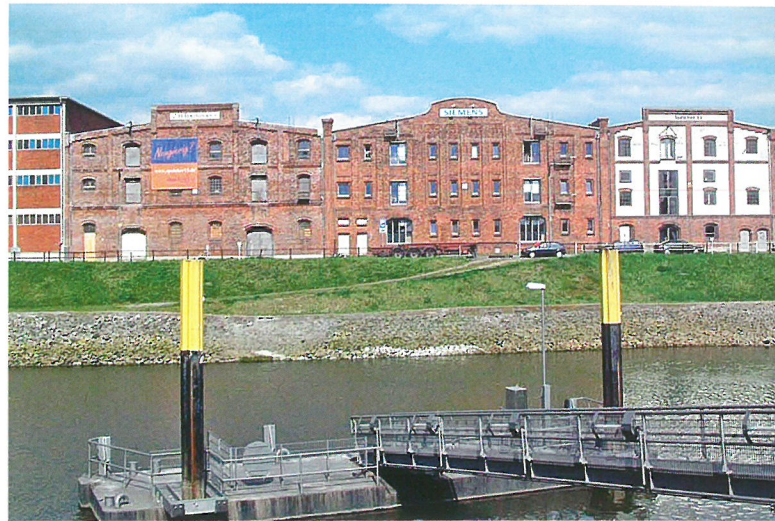
Abb. 12: Bremen, Fabrikenhafen, Bachmannspeicher
