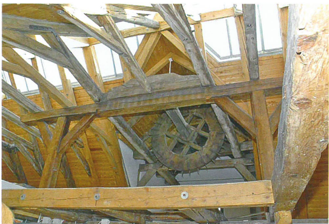
Abb. 8: Bremen, Vegesack, Lange-Speicher; 1805, Innenkonstruktion mit Winde
