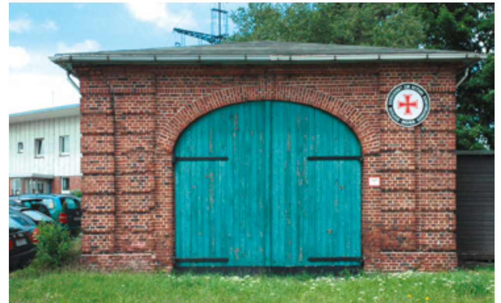
Bremerhaven: Bootsschuppen der DGzRS – Einfachste Architektur mit hohem Denkmalwert
