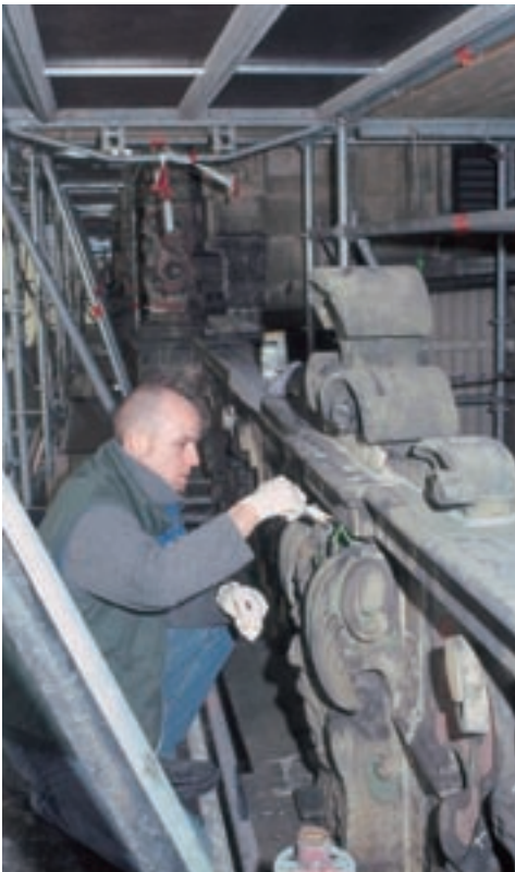
Restauratorenarbeit hinter der Plane auf dem Gerüst
