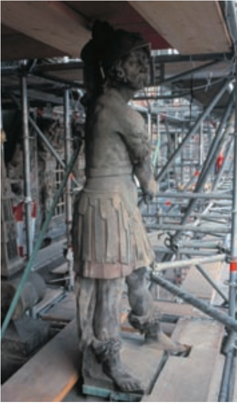
Das Rathaus während der Sanierung 2001–2003
