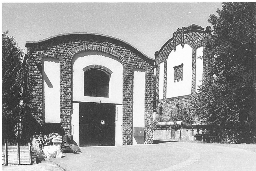
Abb. 16: Friedrichsthal, Schacht Maybach-Ost, Fördermaschinenhaus und Schachthalle (Fotos: Skalecki)
