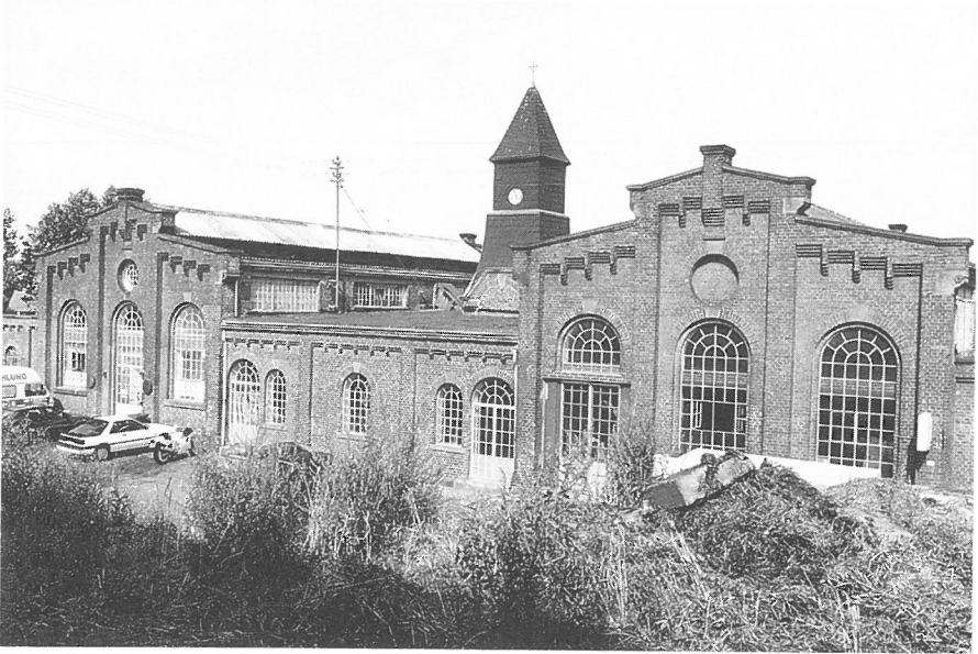
Abb. 19: Köllerbach-Engelfangen, Schacht Victoria 3, Zechenhaus mit Waschkaue
