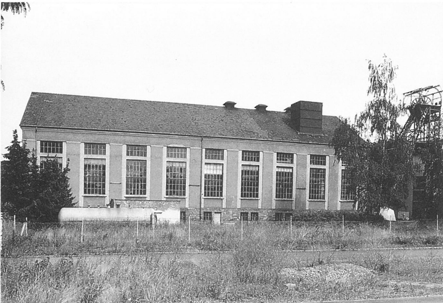
Abb. 10: Schwalbach, Ney-Schacht, Fördergerüst und Maschinenhaus (Fotos: Skalecki)
