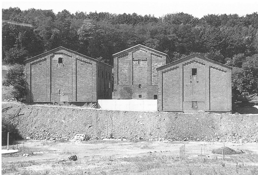
Abb. 14: Maybach, Schachtanlage, Fördermaschinenhäuser (Fotos: Skalecki)
