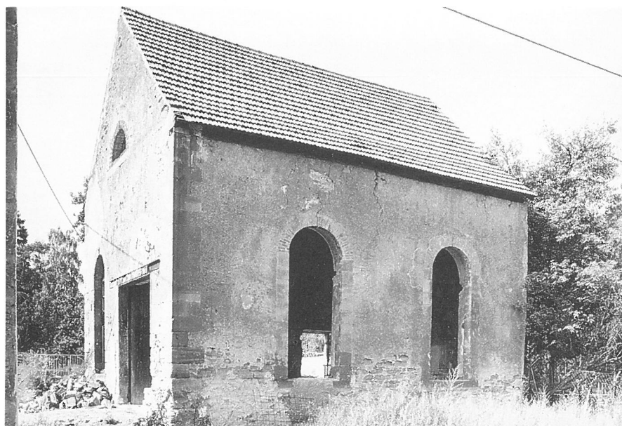
Abb. 13: Schaffhausen, Grube Hostenbach, Fördermaschinenhaus
